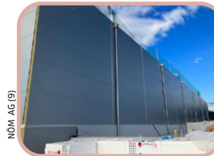
Außenfassade aus gedämmten Paneelen, vorbereitet für eine PV-Anlage
