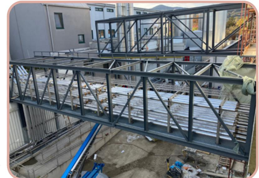
Rohrbrücke für Versorgung mit allen Medien, von Milch, Wasser, Luft bis Dampf
