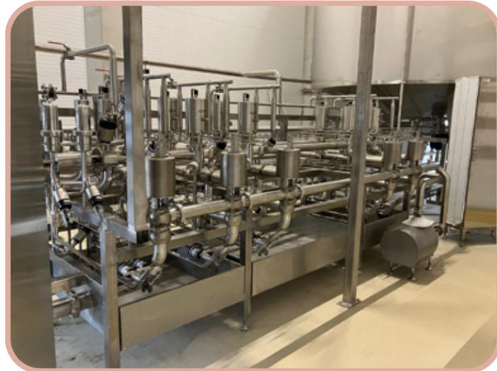
Steriler Ventilknoten zur Verbindung der Tanks, UHT-Anlage und Abfüll-Anlagen
