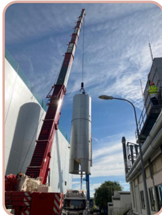
Verhebeaktion des CIP-Tanks, 3 x 30.000 Liter für die Reinigung
